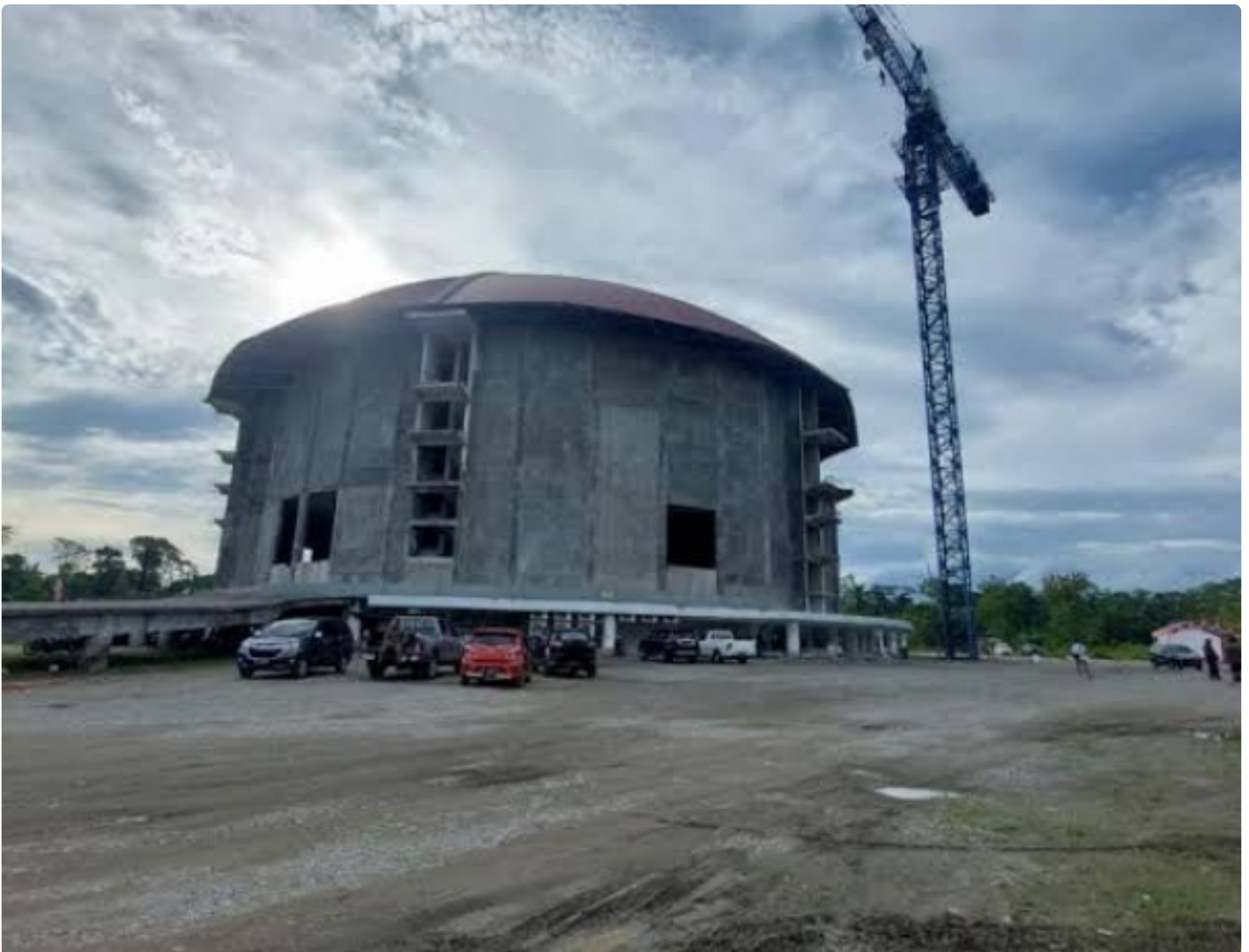
Pembangunan Gereja Kingmi Mile 32
